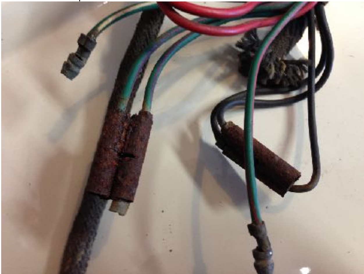
MGA corroded snap connectors
